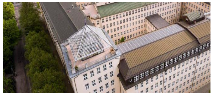
Bild: Anlage am Standort München
