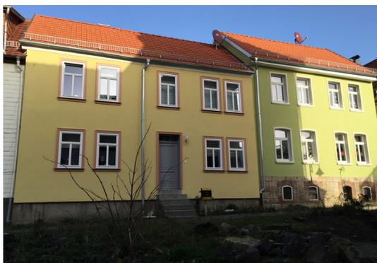
Die historischen, teils denkmalgeschützten Gebäude wurden 2012 entsprechend der Sanierungsbestimmungen kernsaniert. Unter Verwendung nachhaltiger Dämmstoffe (Holzfaservolle) wurde die Fassade gedämmt. Ebenfalls wurden dem Denkmalschutz entsprechende Holzfenster eingesetzt, welche auch für ein gutes Raumklima sorgen.
