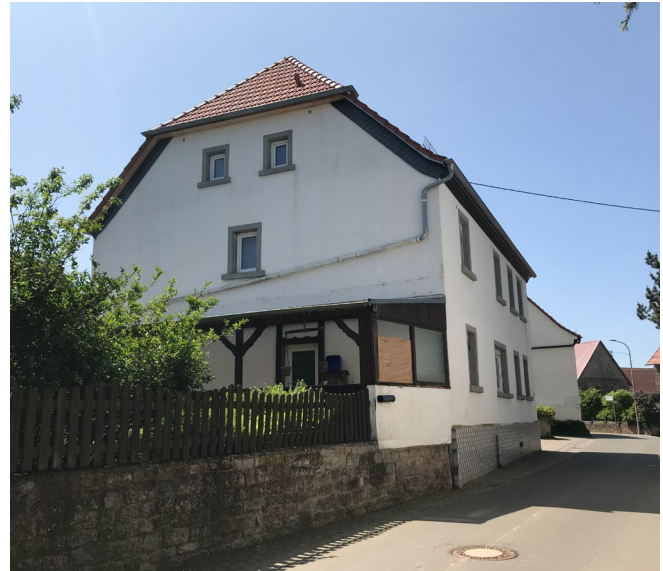
Abbildung 1: Objekt Schneebergerhof, Gerbach
