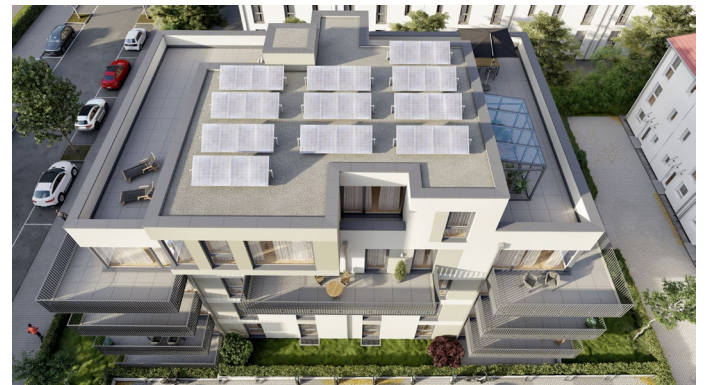
Abbildung 2: Dachansicht des Hauses mit PV-Anlage
