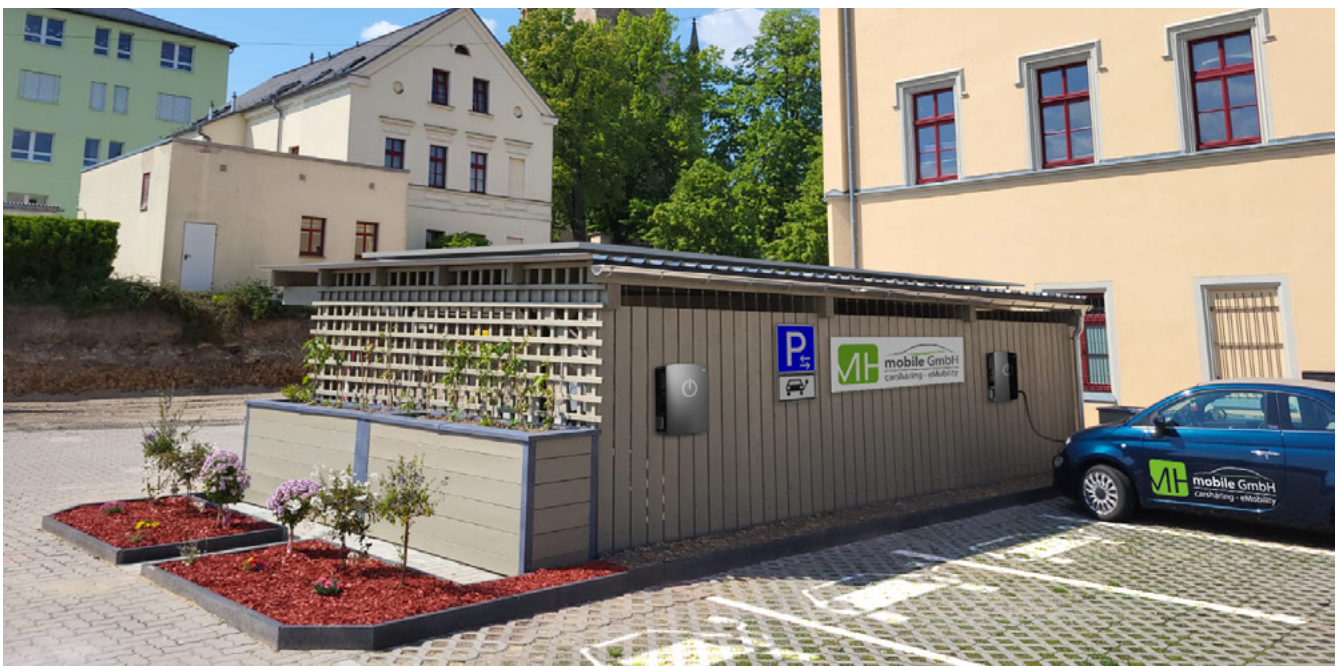
Abbildung 1: Mittlere Carport-Anlage auf dem Kirchplatz 1 in Lengenfeld
