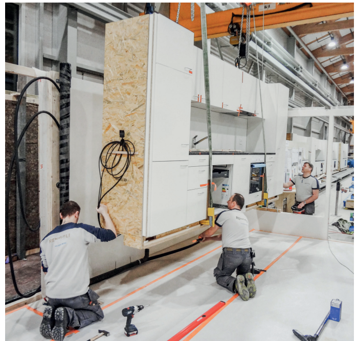
Vorfertigung bei der Renggli AG Schoetz. Einbau einer kompletten Küchenzeile in das Raummodul
