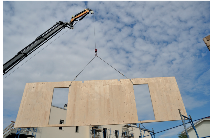
Holzelementbau (2D): Montages eines Wandelements aus Massivholz auf der Baustelle
